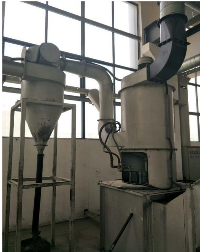
附图 1：废气处理设施
