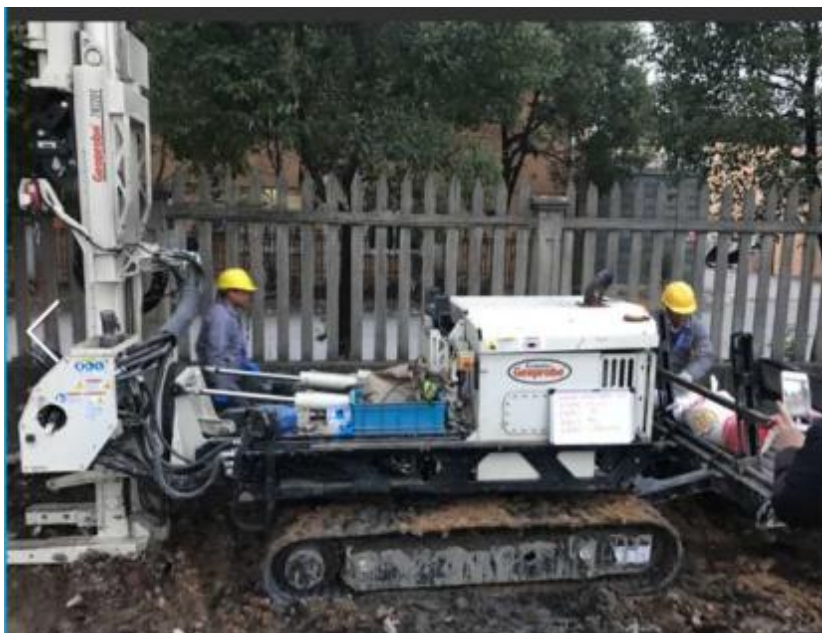
图 7.1-1 美国 Geoprobe 设备进场
