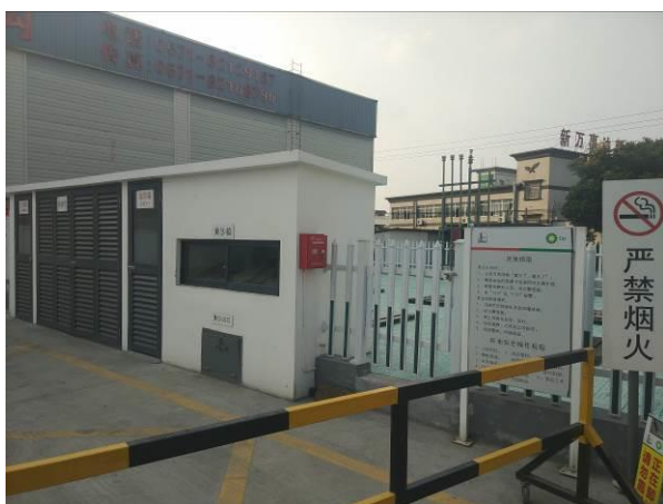
卸油区和放空管
