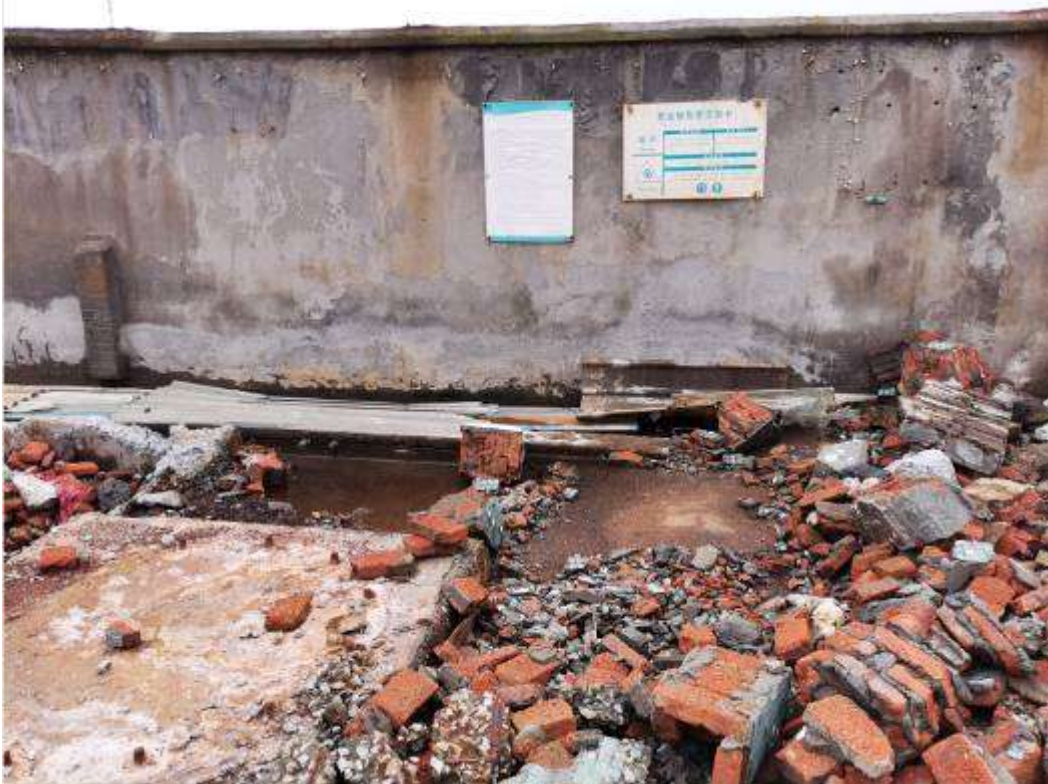
原污水站区域
