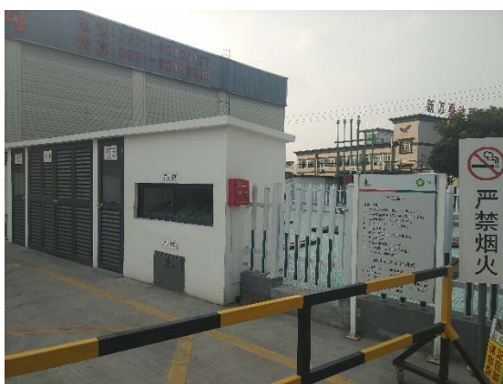
卸油区和放空管
