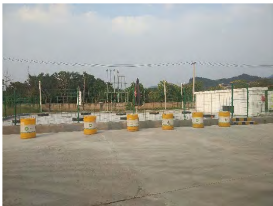
油罐区及排空管
