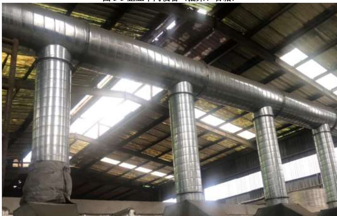
图 3-4 蒸汽发生器（1t）及废气排放口
