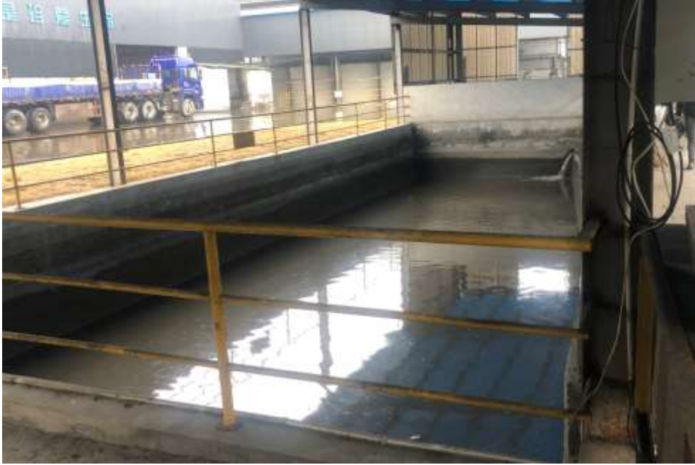
图 3-1 企业雨水收集池
