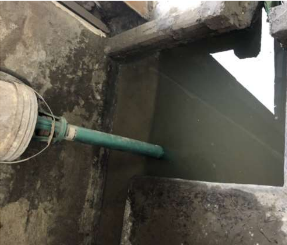
图 3-2 车间清洗废水收集池
