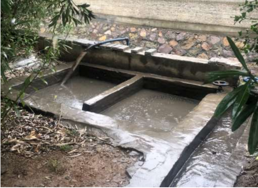
图 3-1 企业雨水收集池
