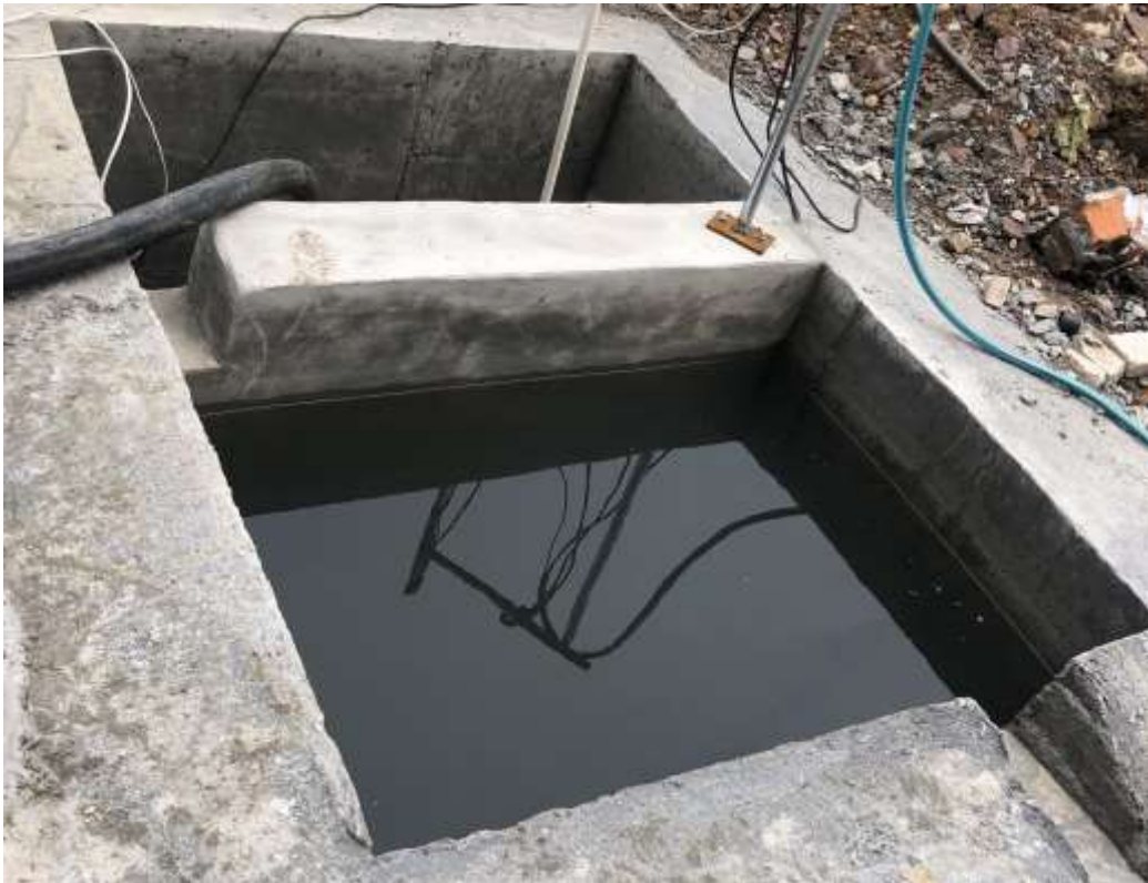
图 3-2 车间清洗废水收集池
