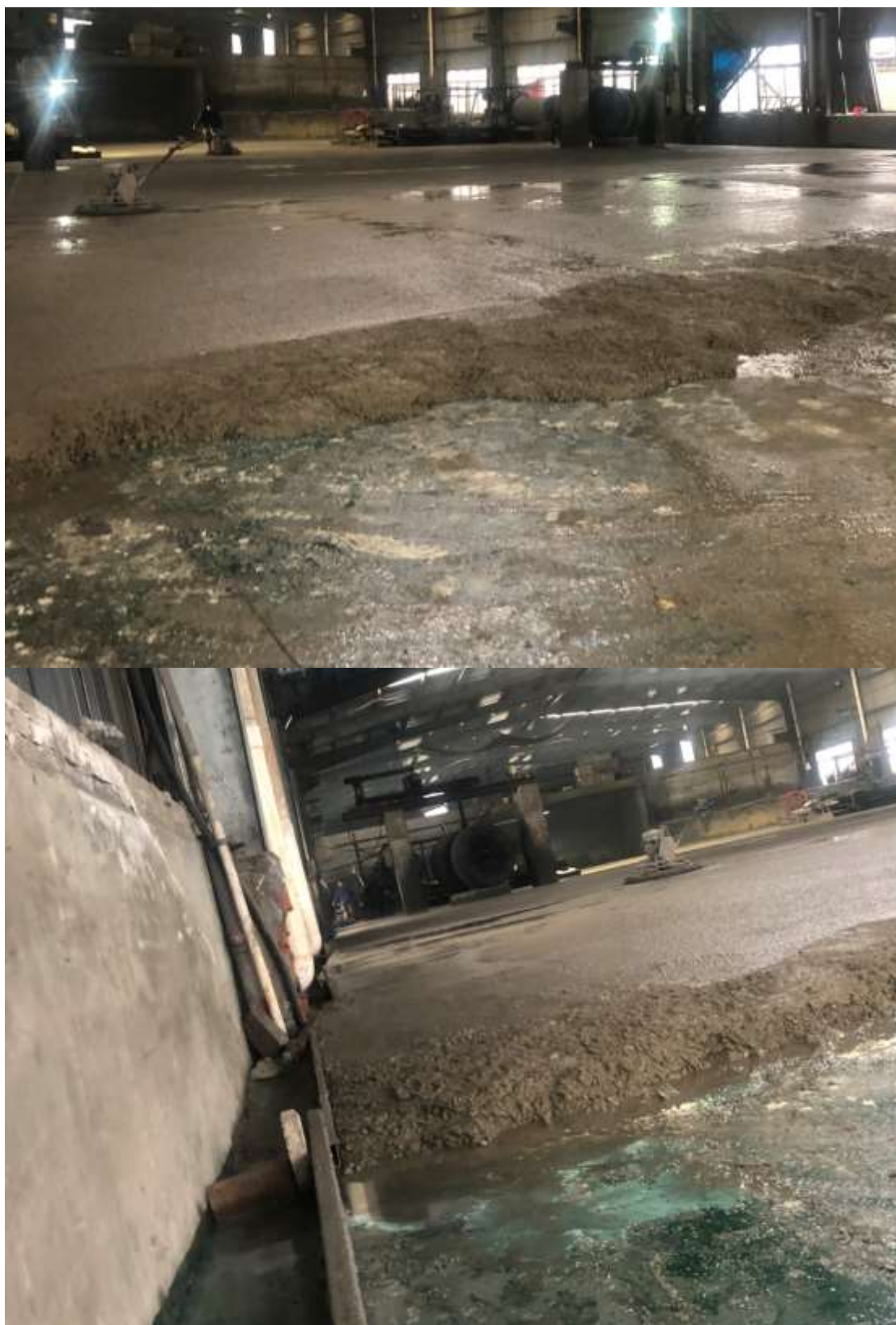
附件四：湿法碾磨车间防腐防渗照片（现场作业照片）
