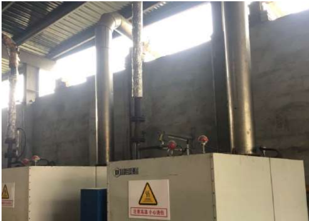
图 3-4 蒸汽发生器（1t）及废气排放口
