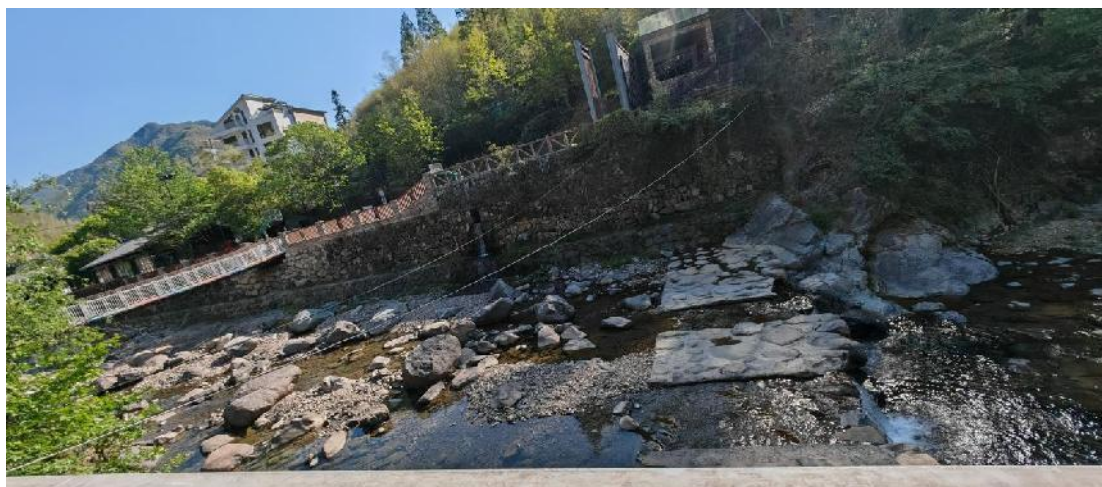
图 3.1-5 地块附近河流龙王溪现状照片
