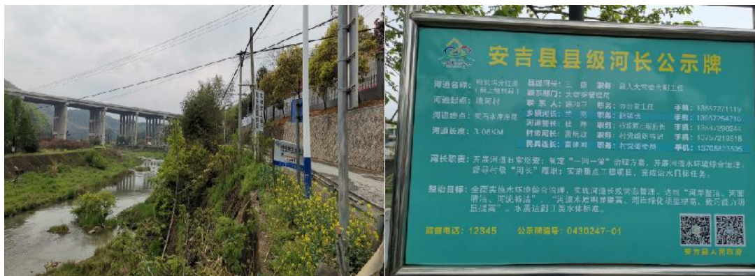
图 3.1-5 地块附近河流现状照片
