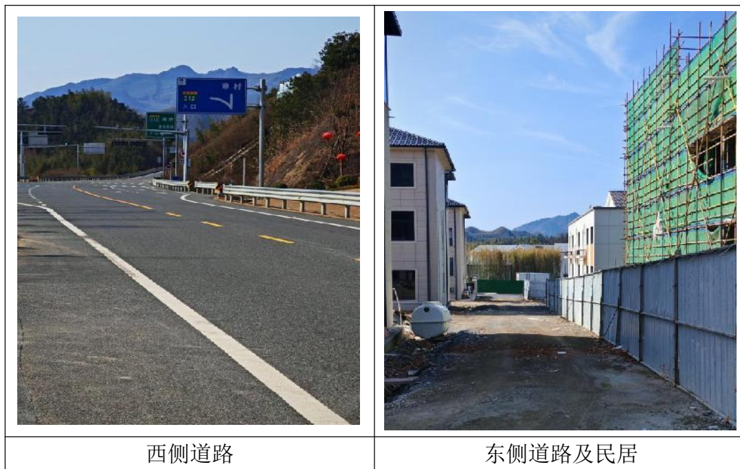
图 3.4-2 相邻地块现状照片
