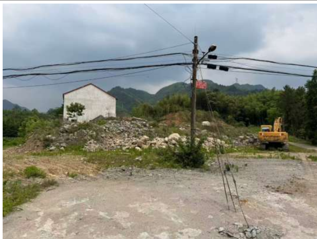
安吉县春豪家具厂原厂址 (地块内构筑物基本上已拆除)
