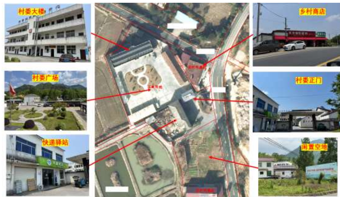
图 3.3-2 调查地块内现状分布情况（航拍俯视图）
