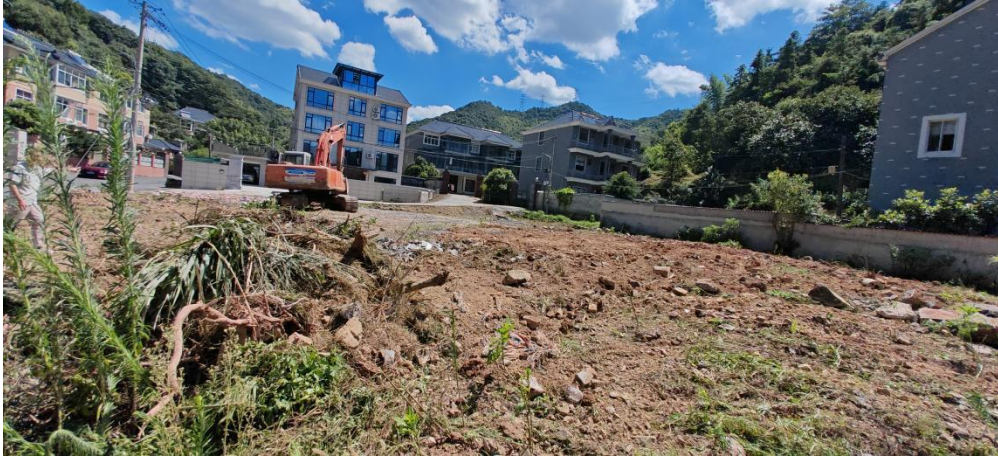
图 3.3-1 地块内现状照片
